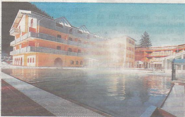
Kurzentrum Bad Eisenkappel/KK
