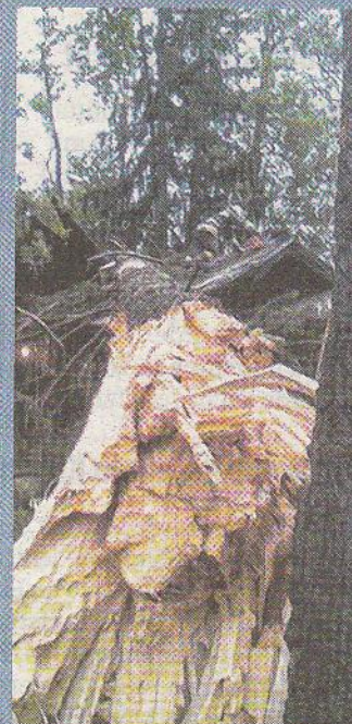
Fichte fiel auf Haus FF BODENSDORF
